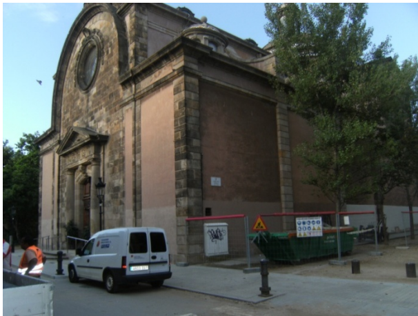
FOTO 3. Estat inicial del lloc de la intervenció
