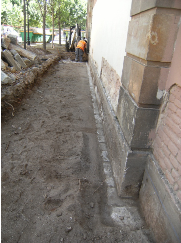
FOTO 27. Detall del paviment original de la capella en la rasa 2
