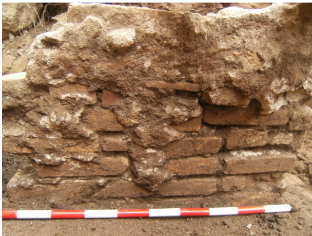
FOTO 19. Detall del mur UE 10
