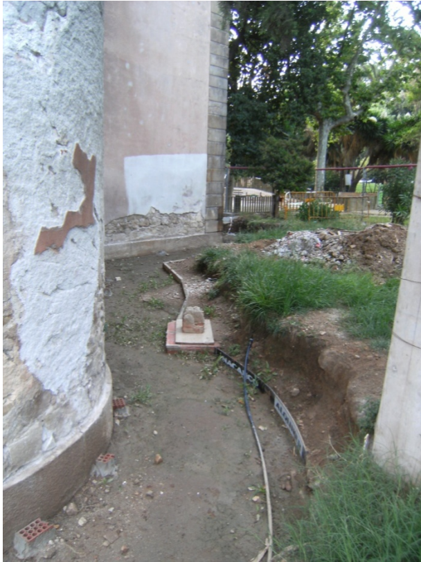
FOTO 5. Estat inicial del lloc de la intervenció
