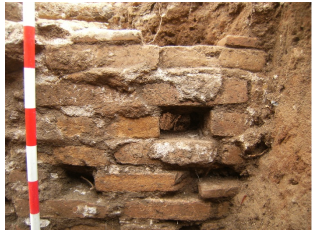
FOTO 20. Detall del mur UE 21
