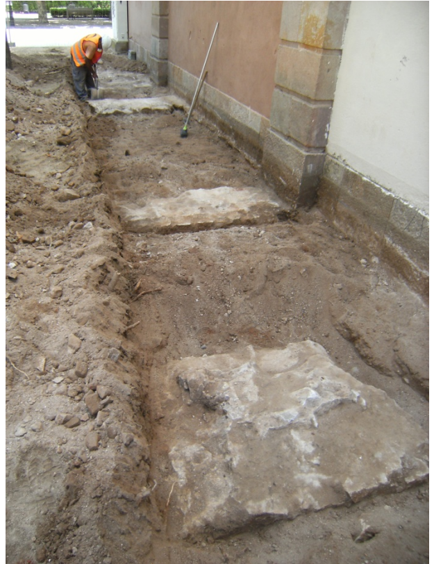
FOTO 28. Murs dels cossos annexos de la capella (Rectoria)
