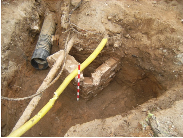
FOTO 17. Estructura del convent de Santa Clara (UE 10 i 21), un cop efectuada la cala 1
