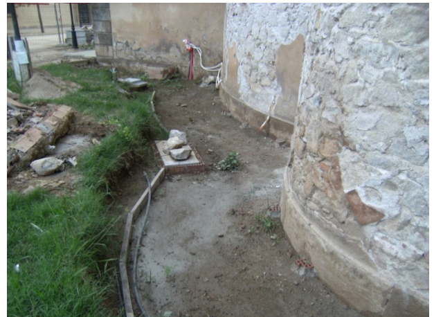
FOTO 4. Estat inicial del lloc de la intervenció
