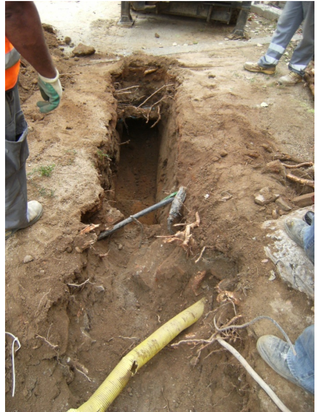
FOTO 10. Tasques d'excavació de la rasa R1
