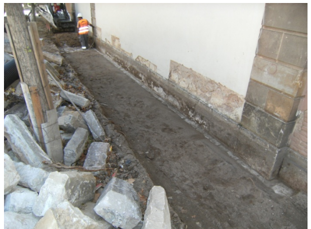
FOTO 26. Final tasques d'excavació de la Rasa 2
