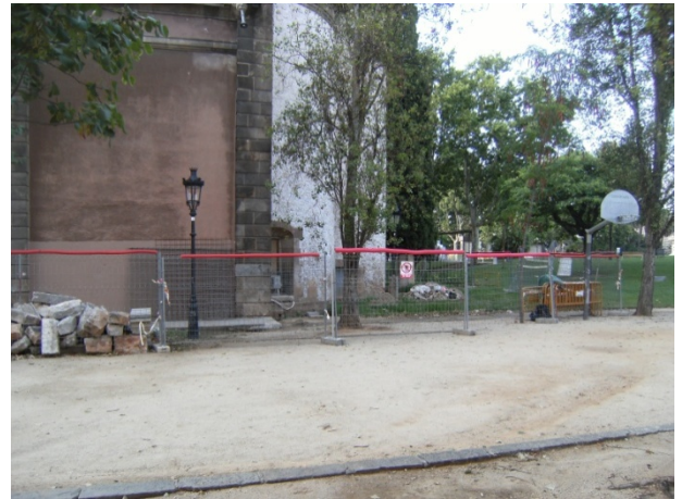
FOTO 2. Estat inicial del lloc de la intervenció
