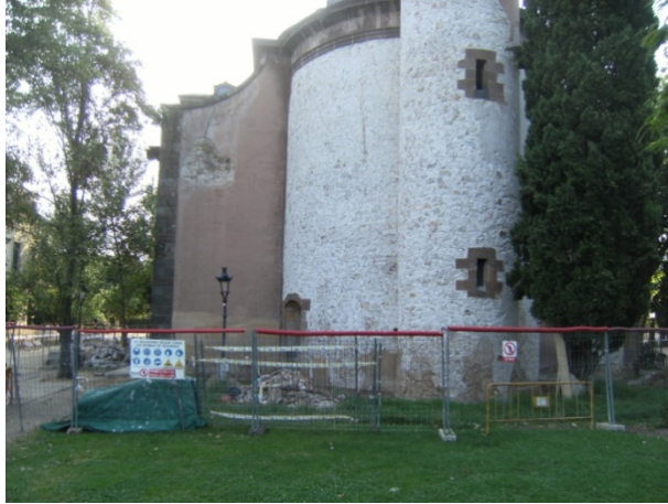
FOTO 1. Estat inicial del lloc de la intervenció
