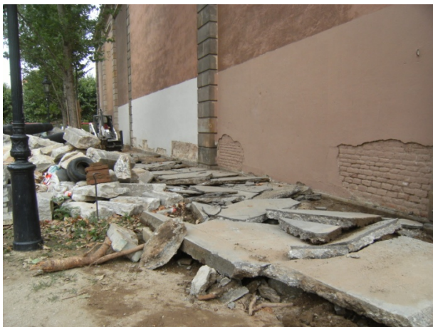
FOTO 25. Tasques d'excavació de la vorera nord de la capella (R2)
