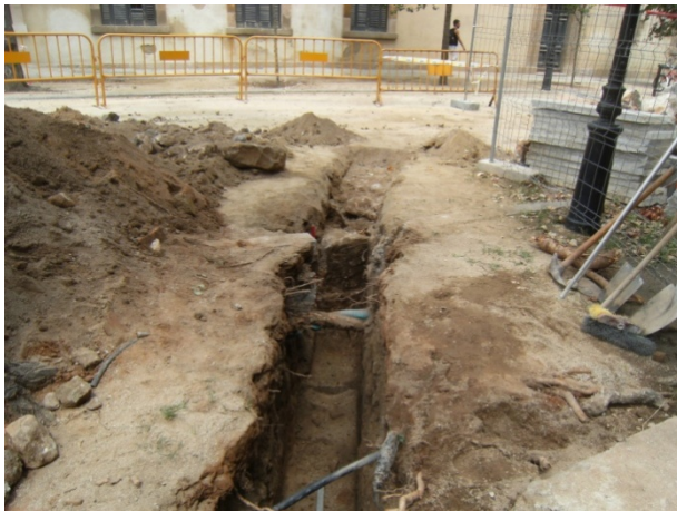
FOTO 11. Final d'excavació de la rasa 1. Al fons s'observa el mur perimetral del clos de la capella (UE 11)
