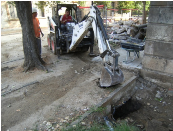
FOTO 9. Inici de les tasques d'excavació de la rasa R1
