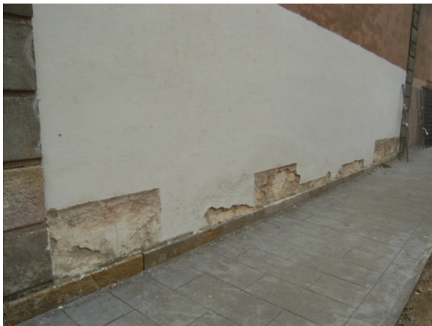
FOTO 7. Estat inicial del lloc de la intervenció
