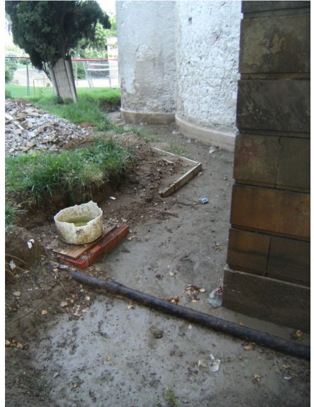
FOTO 6. Estat inicial del lloc de la intervenció
