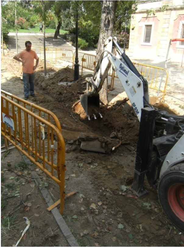
FOTO 31. Excavació de la rasa 3
