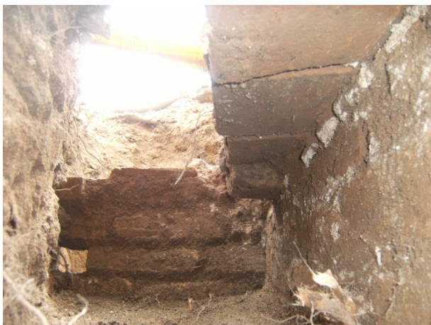
FOTO 21. Detall de l'interior de l'estructura UE 10 i 21
